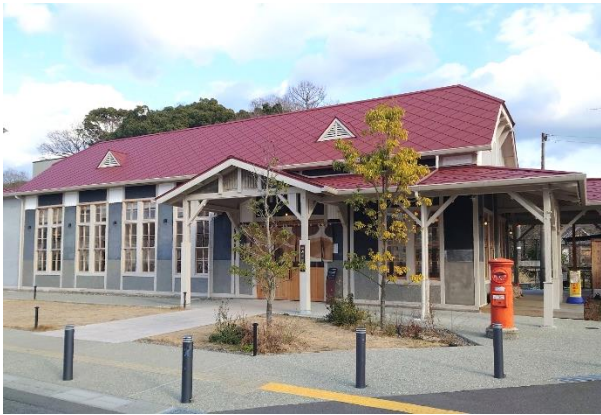
▲外観 菱形の鉄板葺屋根や屋根上のドーマー窓、縦長の上げ下げ窓などを改修工事で復原。
