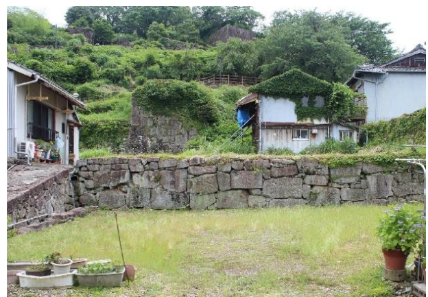
追加指定地内に所在する石垣 （西から）
