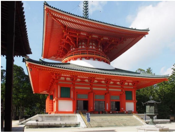
根本大塔外観
