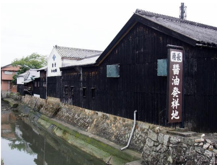
屋敷北側の大仙堀より見た外観
