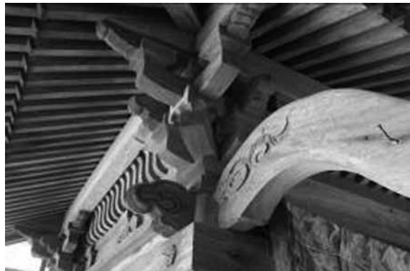
図16 周参見王子本殿 組物詳細
