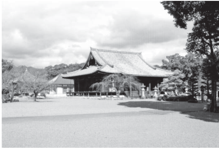
図 22 平成 3 年竣工道成寺本堂
