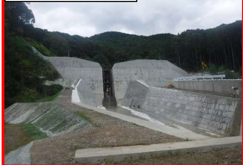
砂防堰堤の新設（荒木川）
