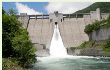
札内川ダムのフラッシュ放流
