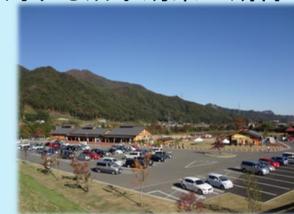
交流施設の整備 (ハツ場ダム)
