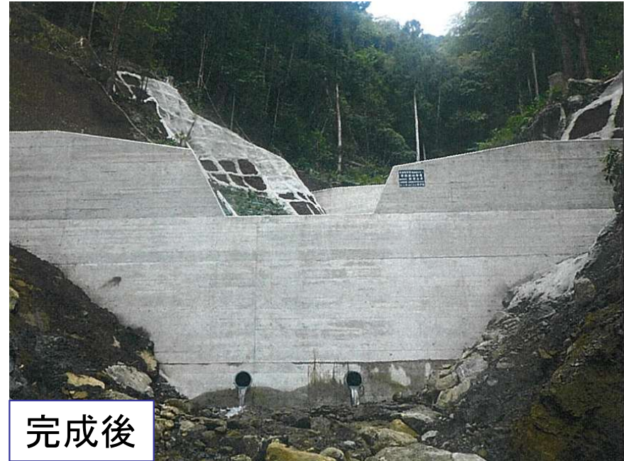
溪間工により復旧
