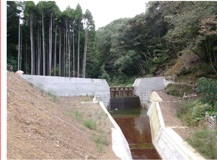
砂防堰堤の新設
