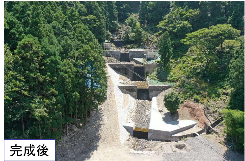
溪間工により復旧
