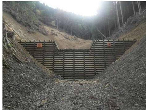
溪間工事の例
