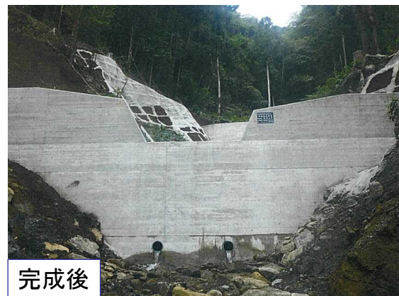
溪間工により復旧
