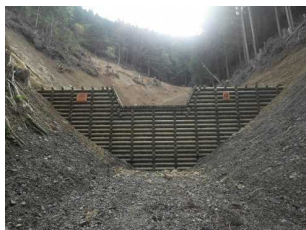
溪間工事の例
