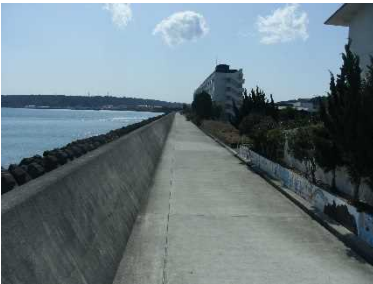
【堤防の嵩上げ】
