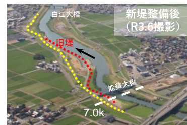
引堤(石川県梯川水系梯川)
