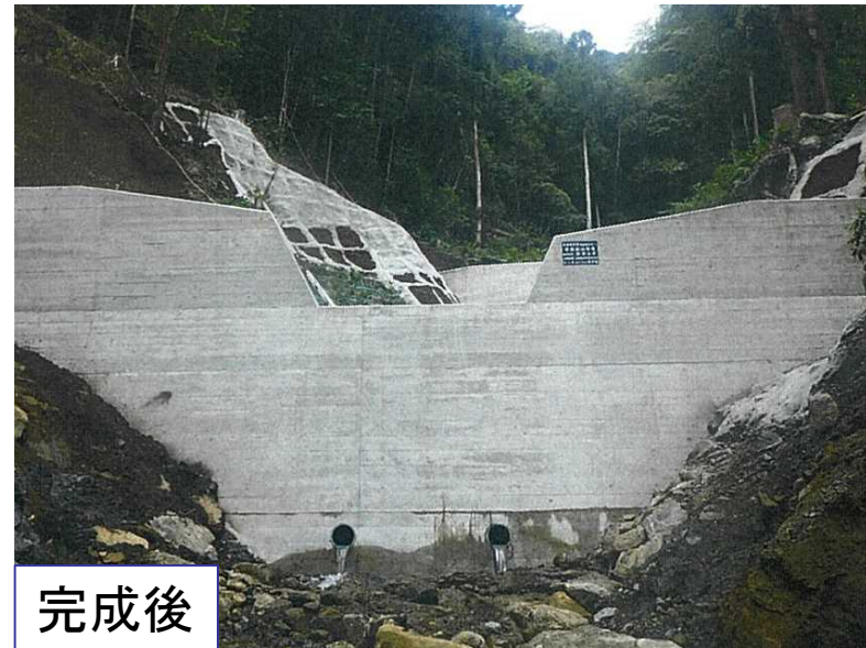
溪間工により復旧
