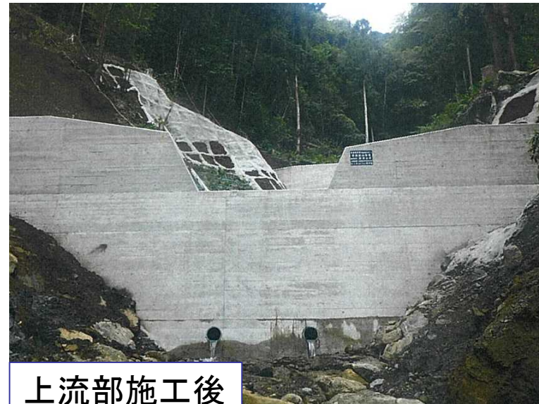
溪間工により復旧
