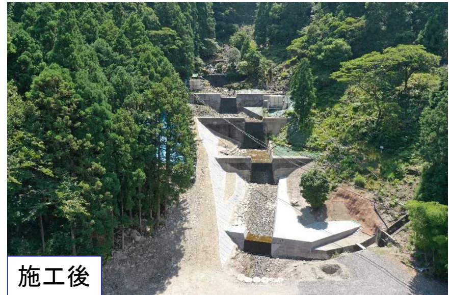
溪間工により復旧
