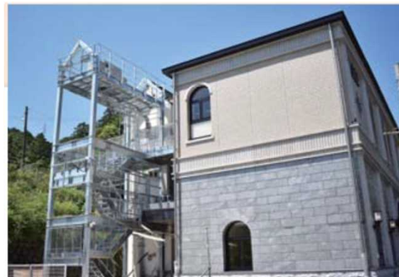
外部避難階段
