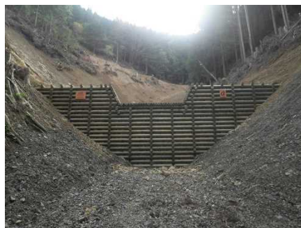
溪間工事の例
