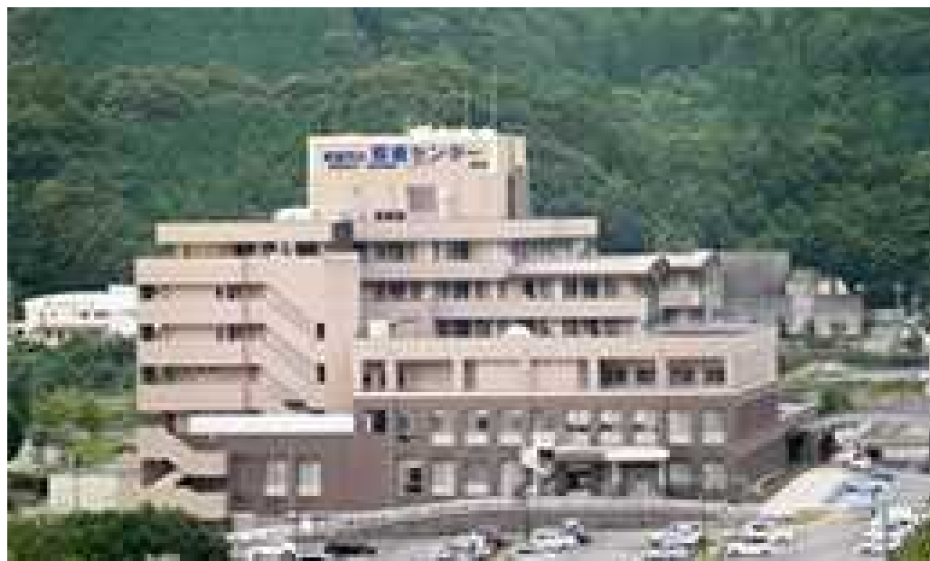
災害拠点病院(新宮市立医療センター)
