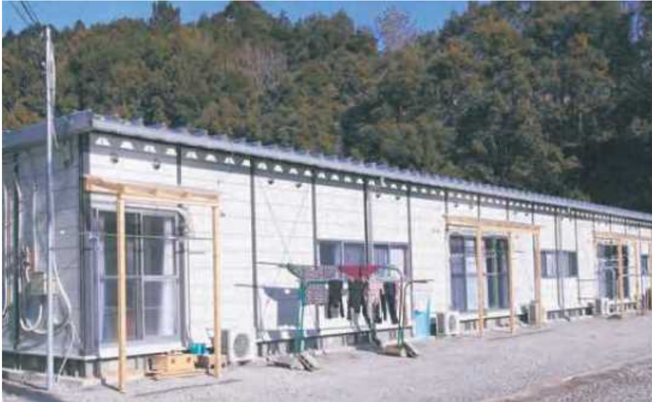
平成23年台風12号 仮設住宅
