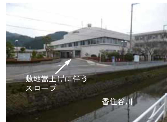
病院の耐水化事例(兵庫県・香住病院)
