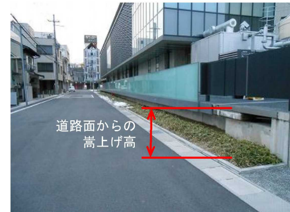
市役所耐水化の例 (兵庫県 豊岡市)
