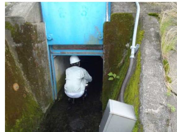
樋門点検状況 (イメージ)
