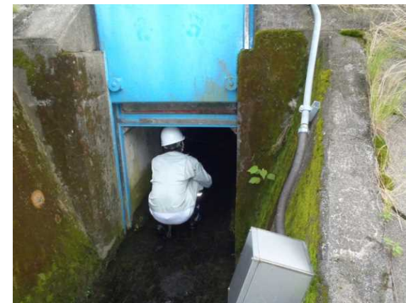
樋門点検状況 (イメージ)
