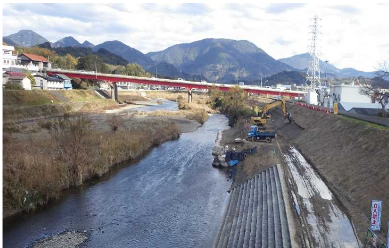
左会津川河川改修
