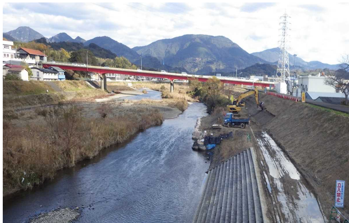
河川改修(左会津川)
