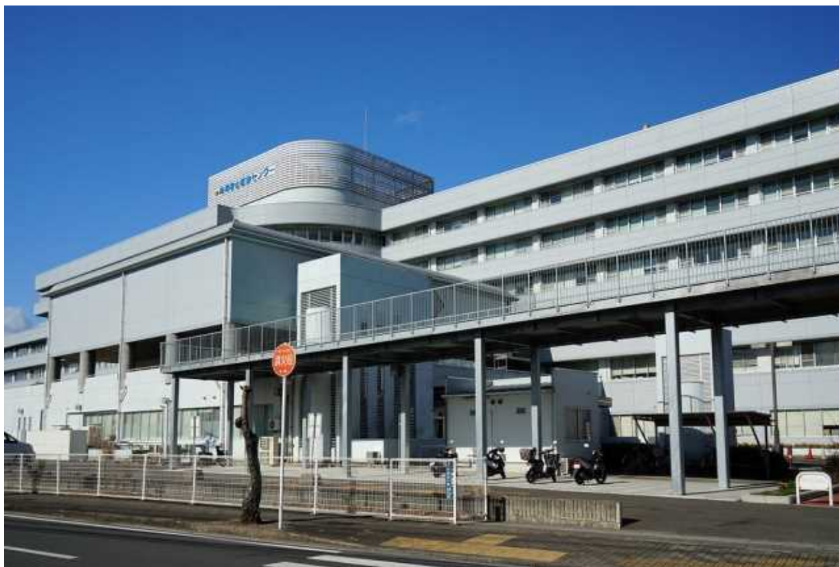
災害拠点病院(南和歌山医療センター)
