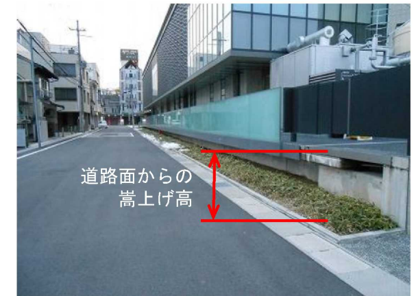
市役所耐水化の例 (兵庫県 豊岡市)
