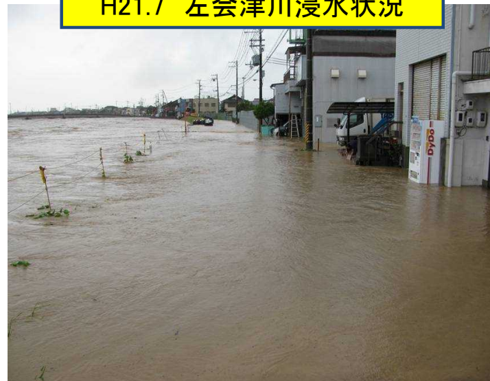
H21.7 左会津川浸水状況
