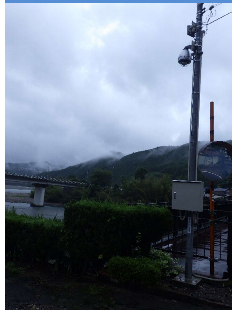
請川橋(四村川)
