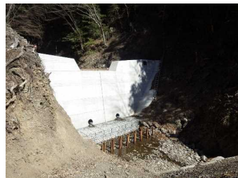
溪間工事（坂泰山国有林）
