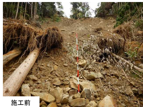
山腹工により復旧
