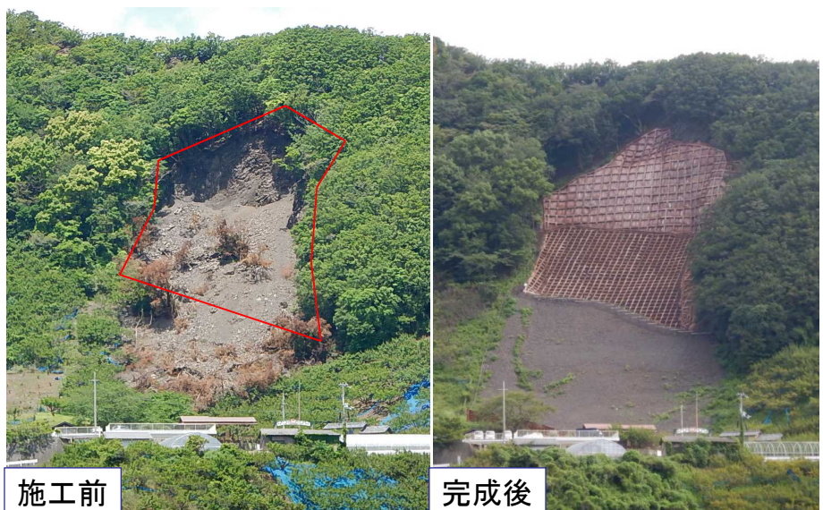
山腹工により復旧
