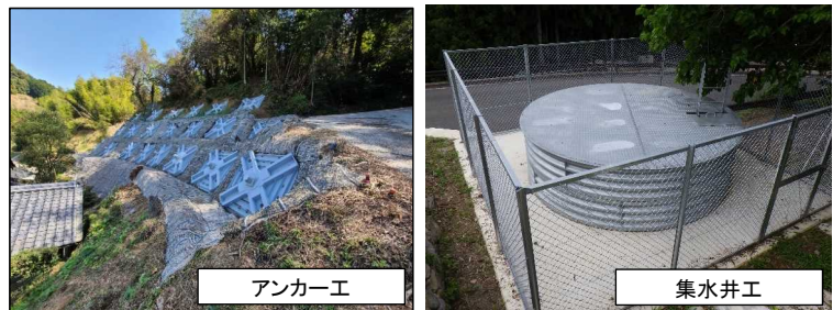
地すべり対策施設の整備
