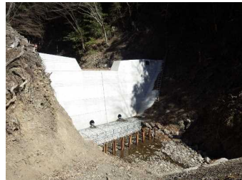
溪間工事（坂泰山国有林）
