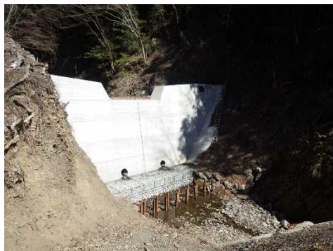
溪間工事（坂泰山国有林）
