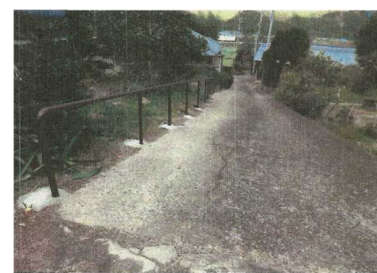
避難路手摺り（塩野区）
