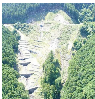
紀伊田辺地区民有林直轄治山事業における山腹工及び谷止工（田辺市 本田垣内区域）
