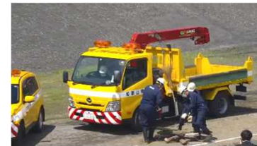
道路啓開訓練
