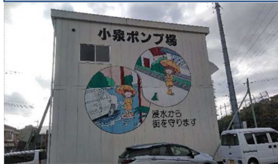
小泉ポンプ場
