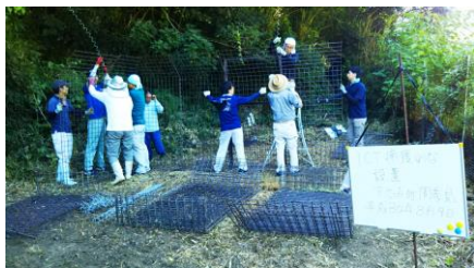
ICT捕獲わなの設置作業
