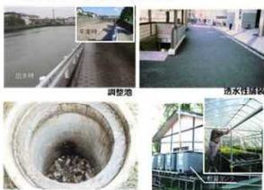
雨水貯留浸透施設の実例
