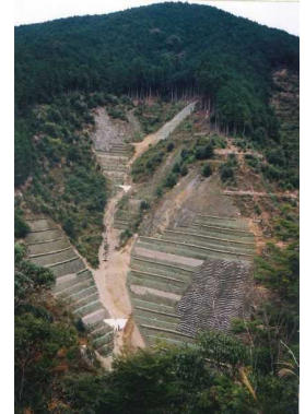
山腹工事の施工状況
