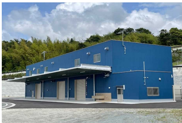
みなべ町防災備蓄倉庫完成(R5. 4月)
