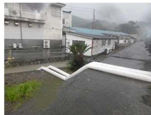
島田地区 水路での排水状況
