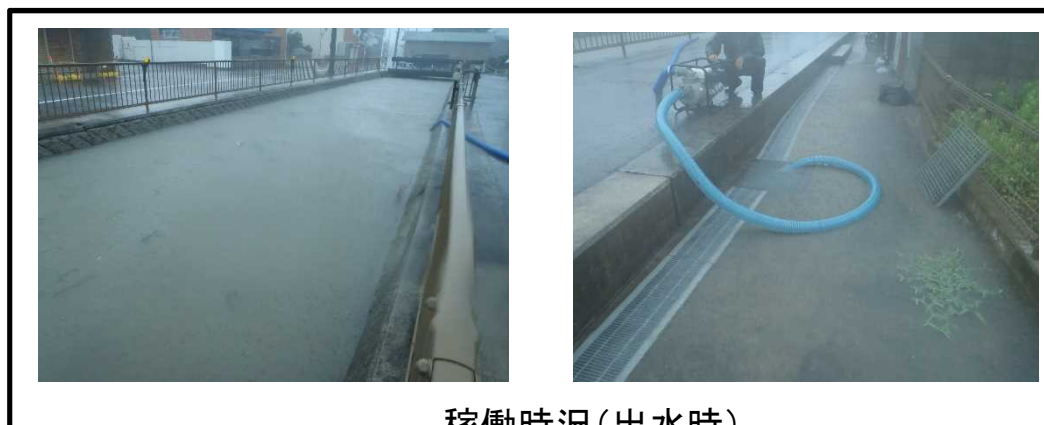
稼働時況(出水時)
