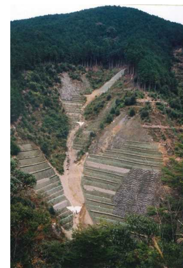
山腹工事の施工状況
