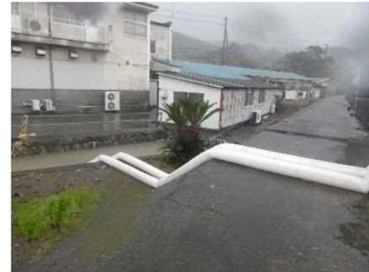
島田地区 水路での排水状況
