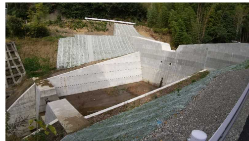
砂防堰堤の新設
