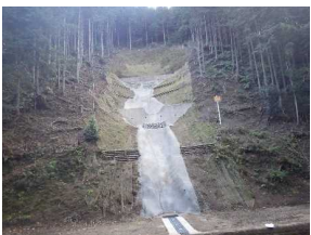
山腹工事 (川又国有林)
