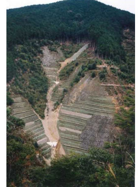
山腹工事の施工状況
