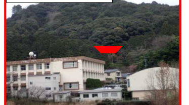
砂防堰堤の新設(あたぎ谷川)
