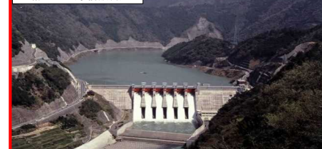
椿山ダム(事前放流)
