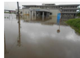
浸水時の状況 (喜多方市提供)
