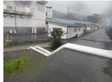
島田地区 水路での排水状況
