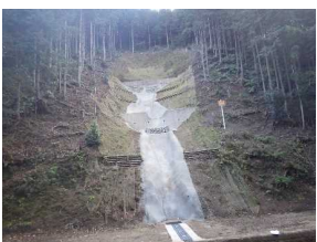
山腹工事 (川又国有林)
