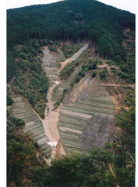
山腹工事の施工状況
