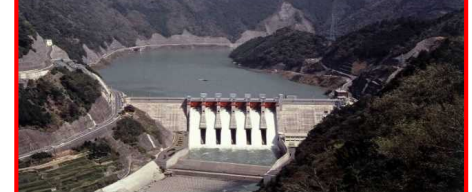
椿山ダム(事前放流)
