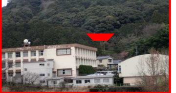
砂防堰堤の新設(あたぎ谷川)
