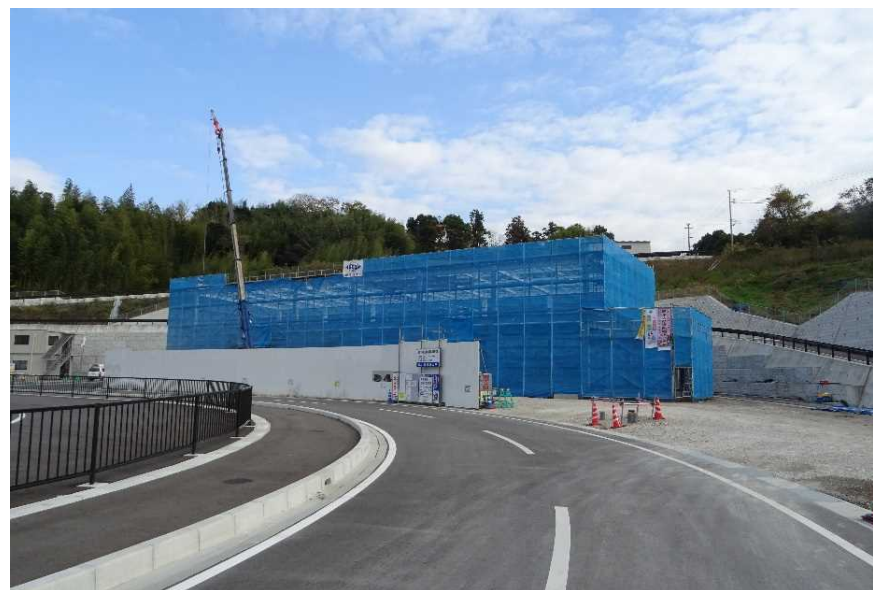
防災備蓄倉庫建設中
