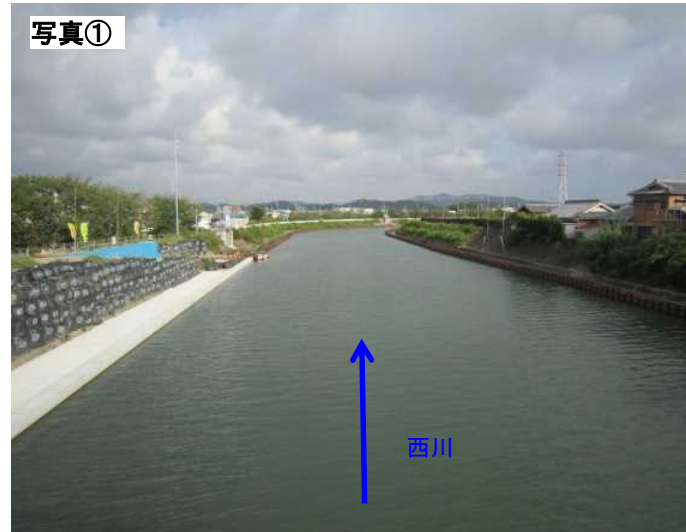
両岸の矢板護岸が整備済の状況(右岸側は笠コン未整備)
