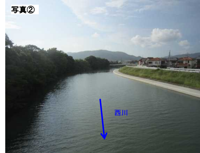
左岸側の矢板護岸が整備済の状況
