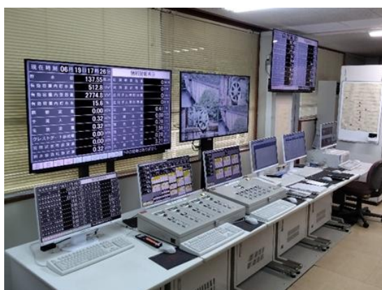
ダム制御処理設備更新状況
