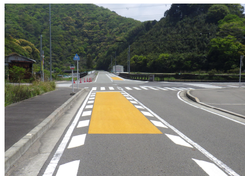
交通安全対策（カラー舗装）
