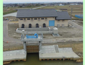
排水機場全景
