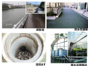
雨水貯留浸透施設の例
