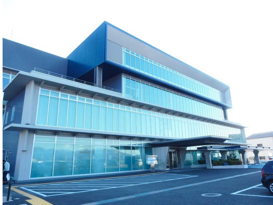
庁舎耐水化の例(湯浅町)
