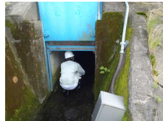
樋門点検状況 (イメージ)
