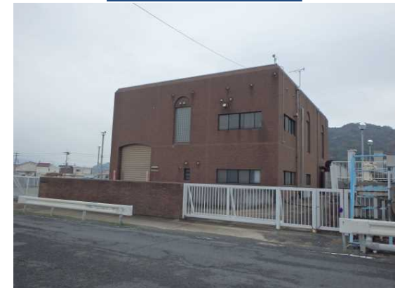
箕川ポンプ場
