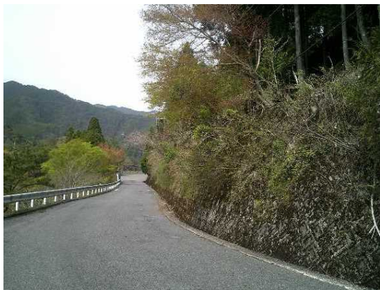
【国道480号（花園久木）工事前】
