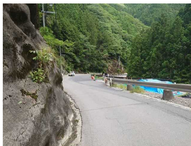
【県道花園美里線（梁瀬2工区）工事中】
