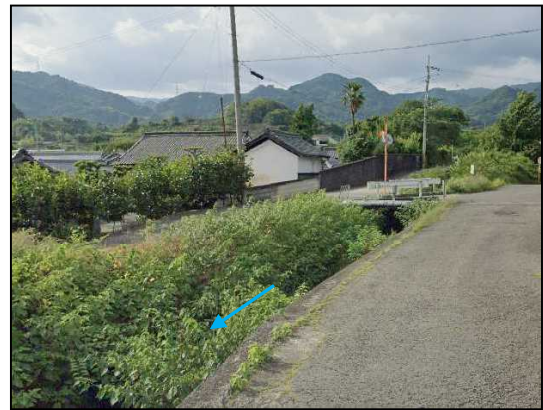
【未整備区間(0.65k 付近)】
