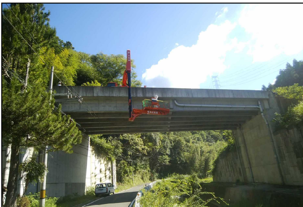
橋梁点検（橋梁点検車）
