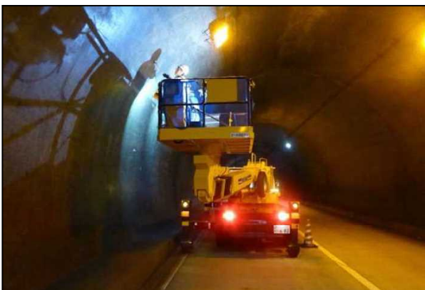
トンネル点検
