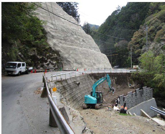
【県道花園美里線（梁瀬1工区 その2）工事中】
