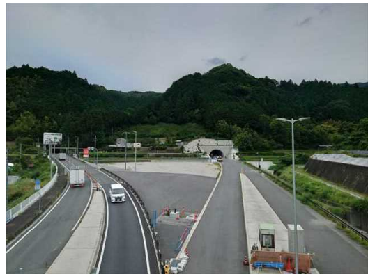
【(仮称)新紀見トンネル和歌山側】
