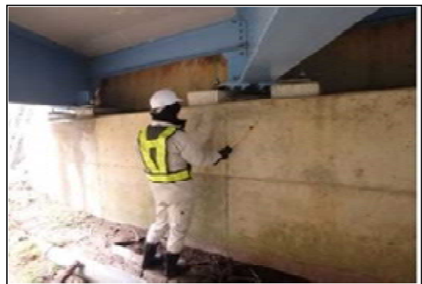
橋梁点検（打音検査）
