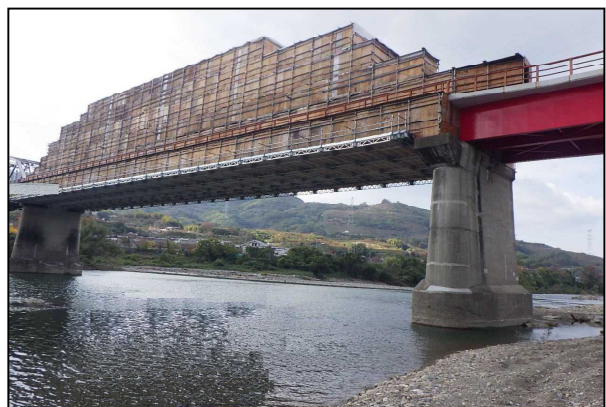
橋梁補修工事
