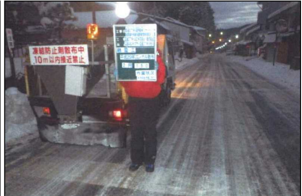
【凍結防止剤（塩化カルシウム）の散布状況】
