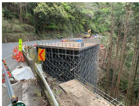
【国道370号（九度山町域）工事中】
