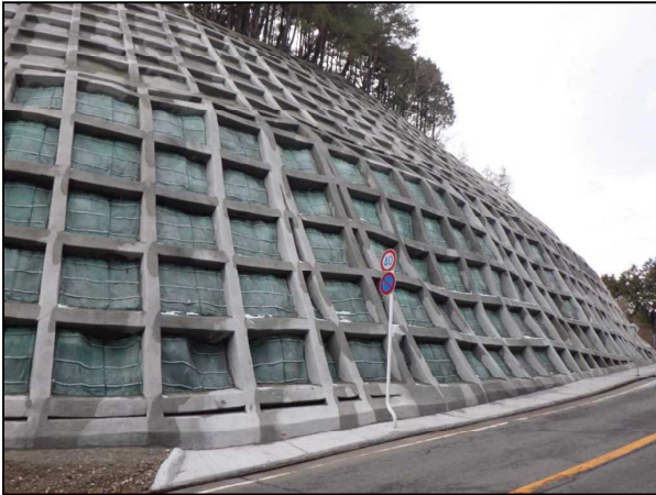
法面補強工事
