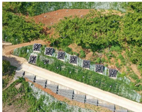
グラウンドアンカー工（Bブロック）
