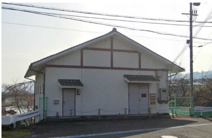
九度山ポンプ場（九度山町入郷）
