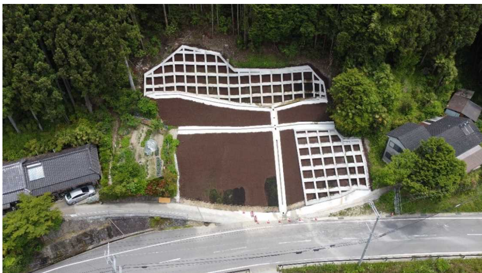
かつらぎ桃山線道路災害復旧工事（紀の川市中瀬瀬）
