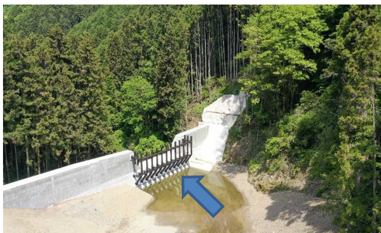
栗の木谷川砂防改築事業（紀の川市神通）
