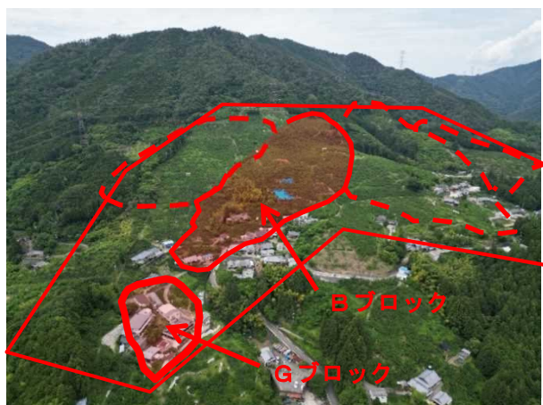
下鞆渚地区地すべりブロック全景
